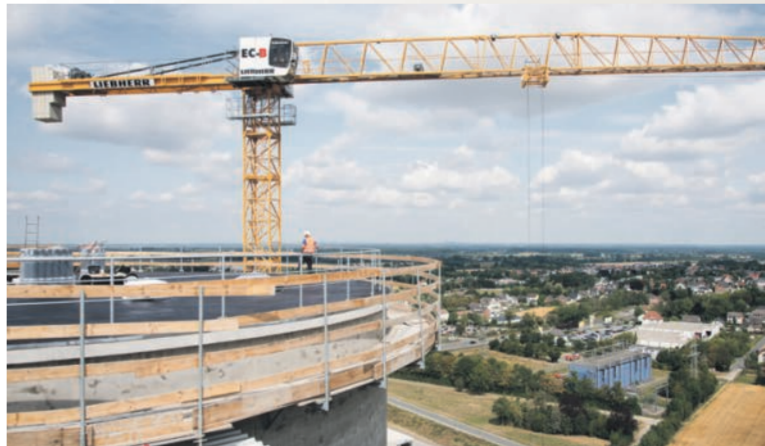
Modernste Technik kommt auf den deutschlandweiten Baustellen zum Einsatz.
